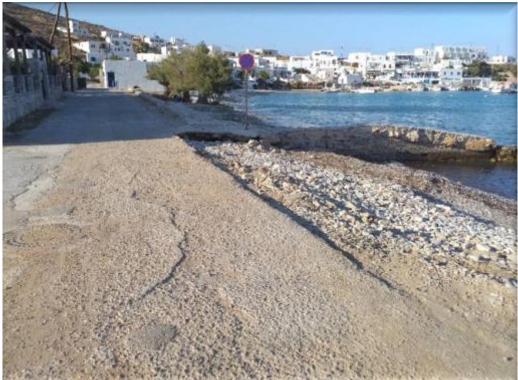
Εικόνα 15. Άποψη πρόσβασης προς την αντίθετη πλευρά, προς τα παραθαλάσσια κτίρια
