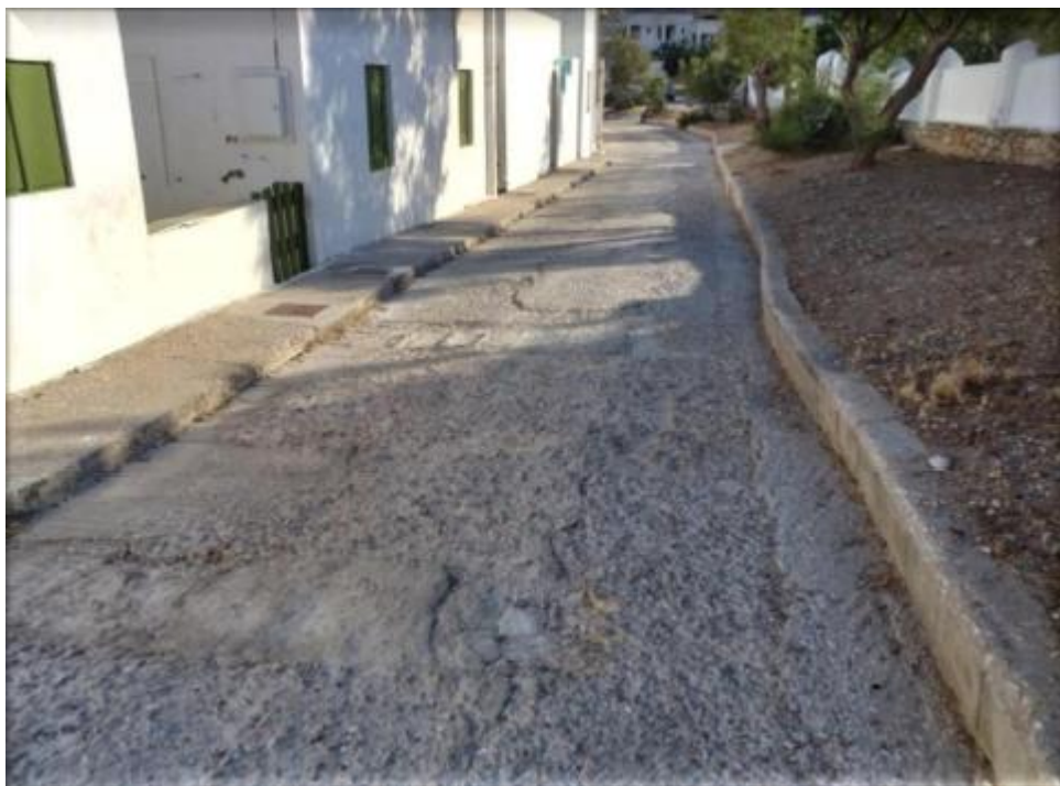
Εικόνα 5. Άποψη κατάστασης οδοστρώματος
