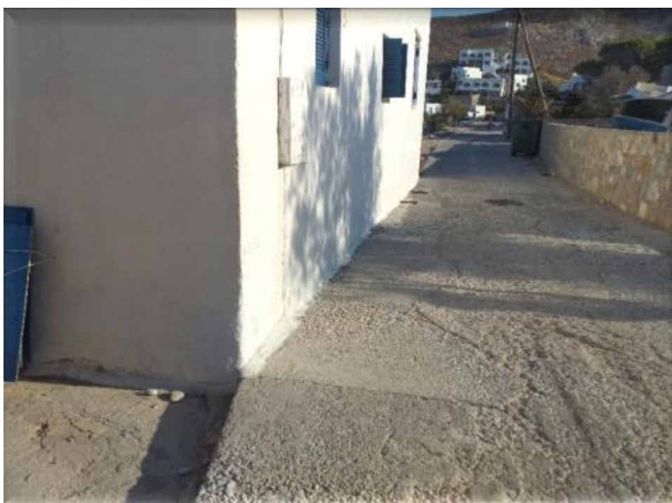
Εικόνα 8. Άποψη υφιστάμενης κατάστασης, σημείο στένωσης
