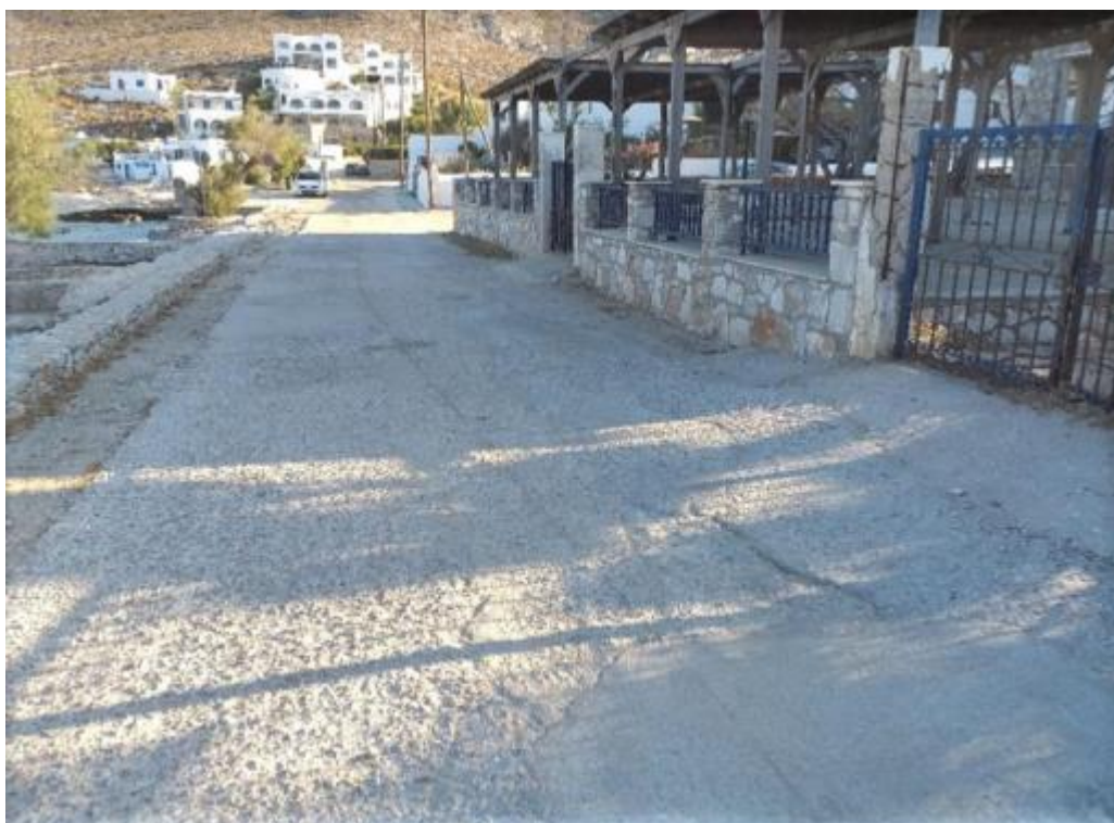
Εικόνα 12. Άποψη παραλιακού τμήματος (οδός κυκλοφορίας οχημάτων στα δεξιά και πεζοδρόμιο στα αριστερά)
