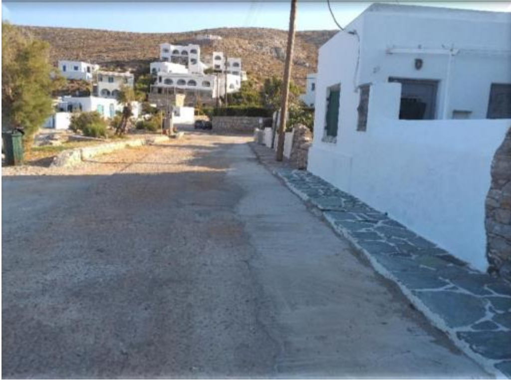
Εικόνα 13. Άποψη υπόλοιπου παραλιακού τμήματος.
