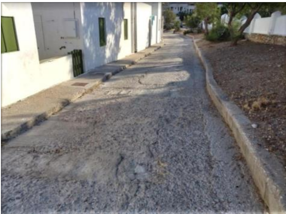
Εικόνα 2. Άποψη κατάστασης οδοστρώματος
