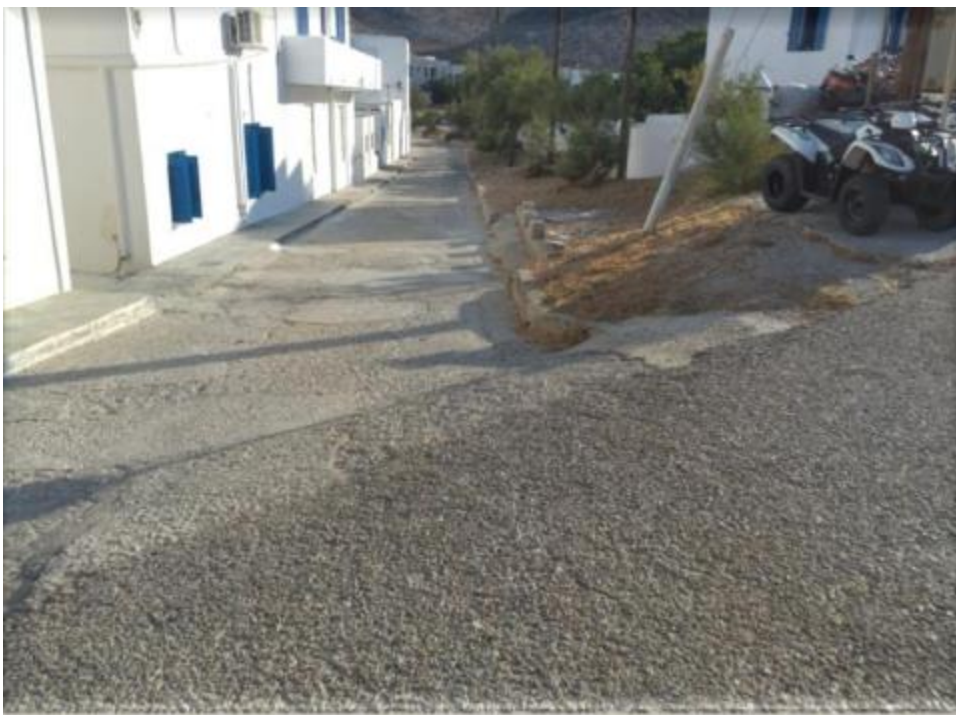
Εικόνα 1. Άποψη εισόδου από επαρχιακή οδό
