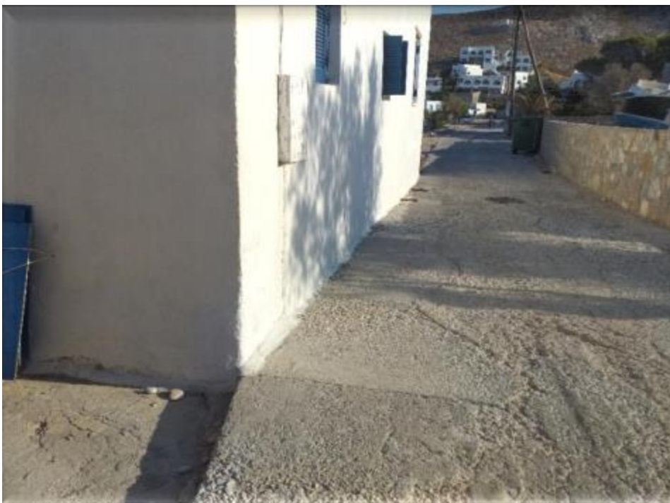
Εικόνα 5. Άποψη υφιστάμενης κατάστασης, σημείο στένωσης
